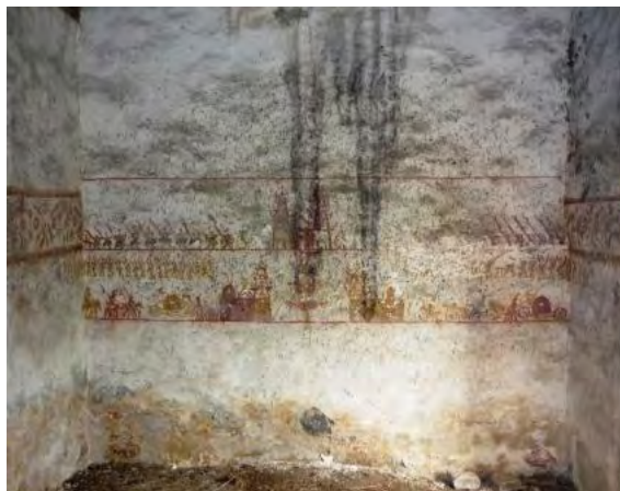
Imagen 7. Muro poniente. Fotografía del autor.
