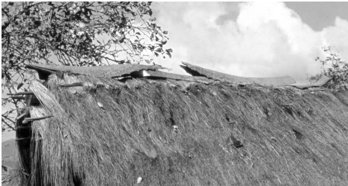
Figura 7. Pencas para reparar el techo (1972).
